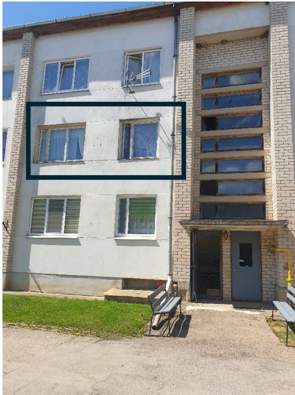
Ēkas fasāde ar dzīvokļa logiem
